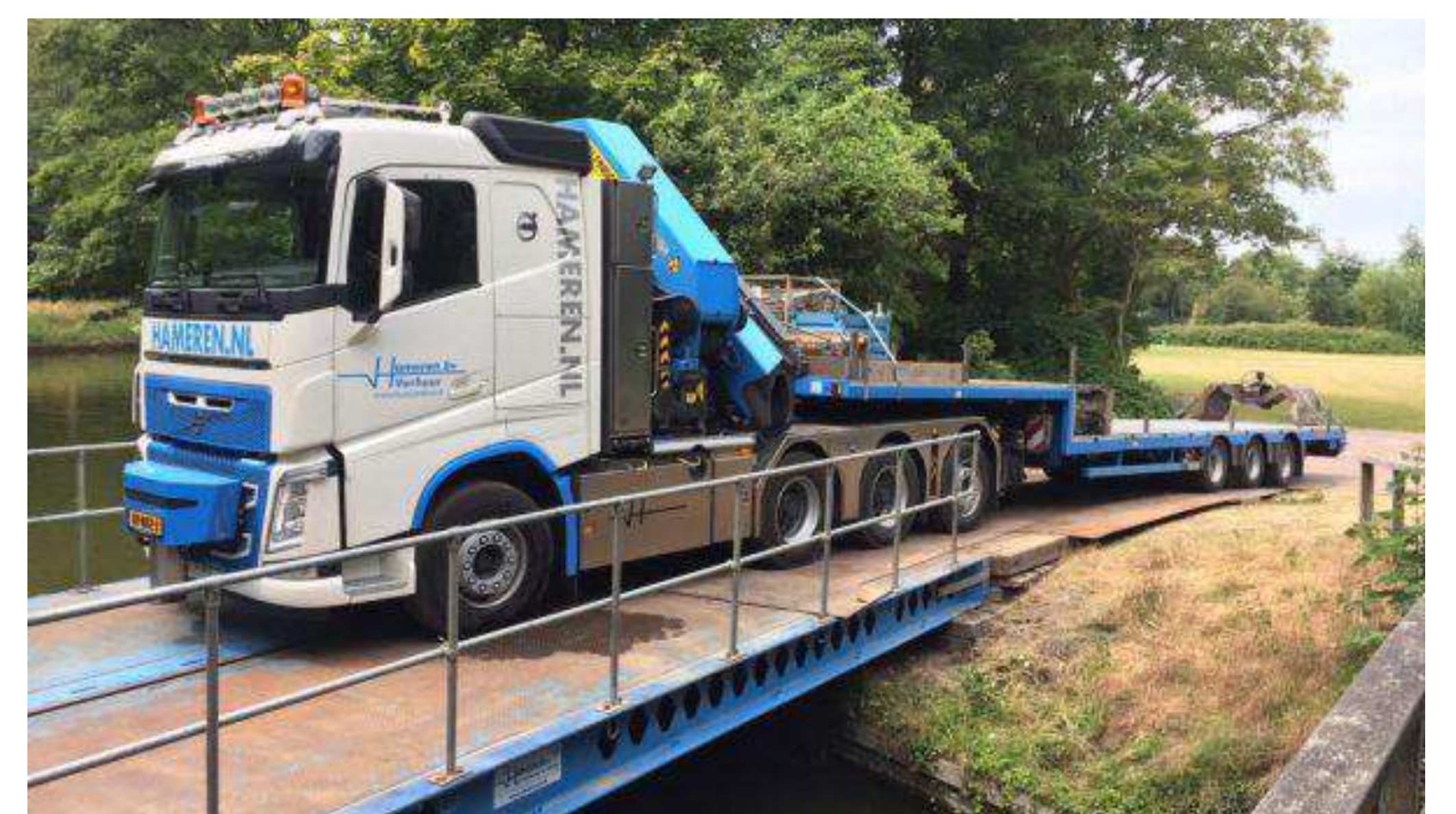
Tijdelijke brug voor het bouwverkeer
