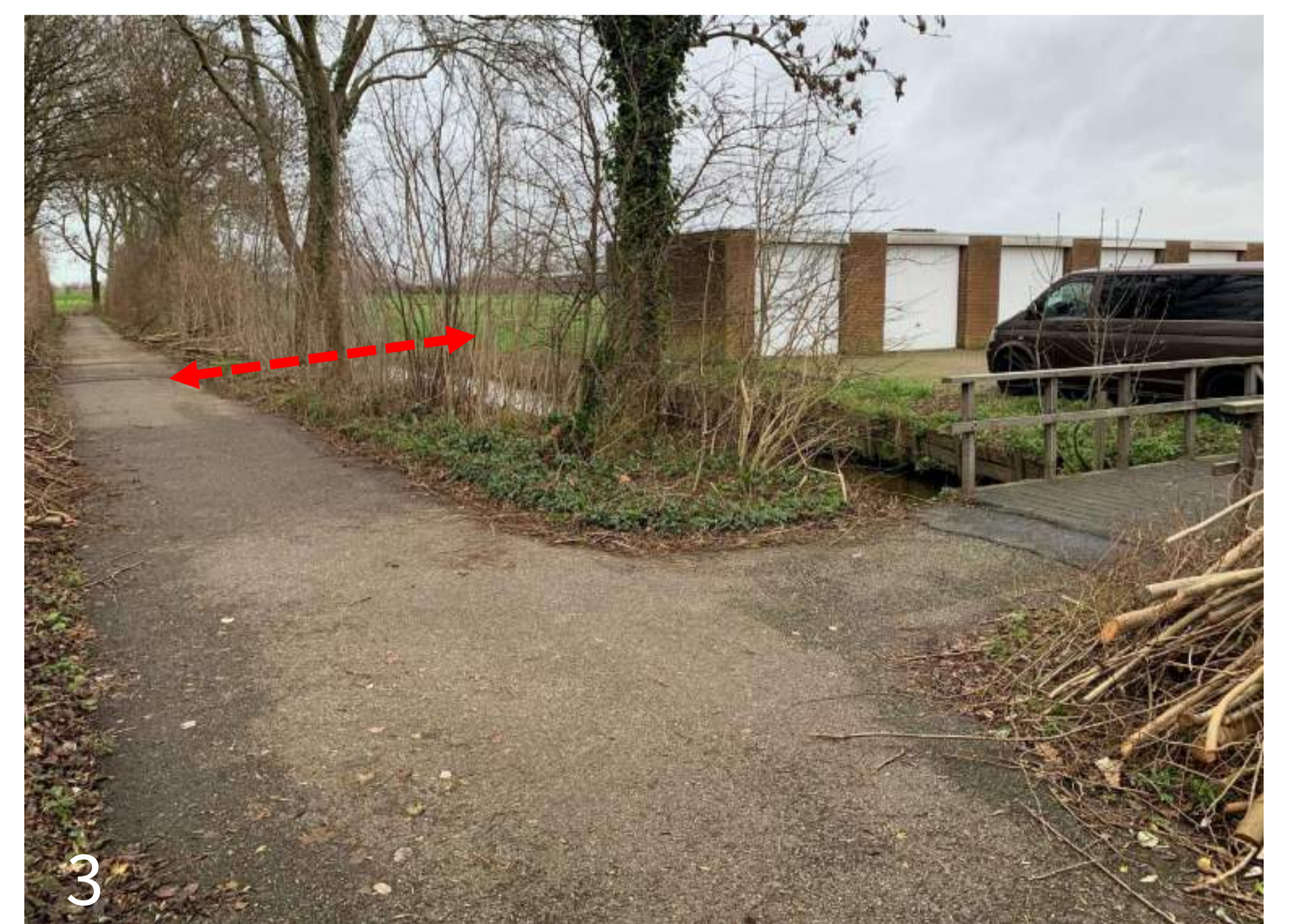
3 Locatie van tijdelijke brug
